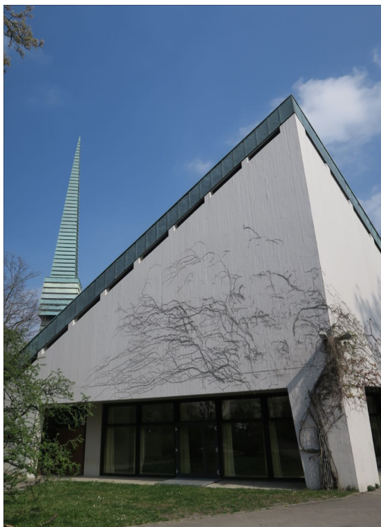
Abb. 12 Sommerrainkirche, Stuttgart-Bad Cannstatt
